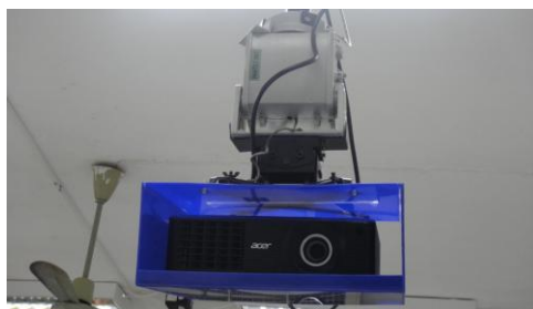
รูปที่ 4.1 ชุดควบคุมโปรเจ็กเตอร์
